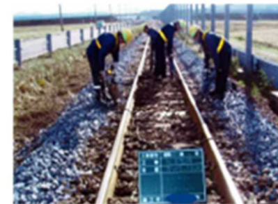
レールの修繕
