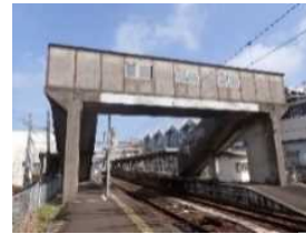
既存施設の 撤去
