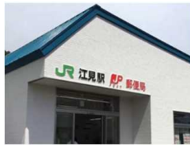
駅舎の 新改築・移設
