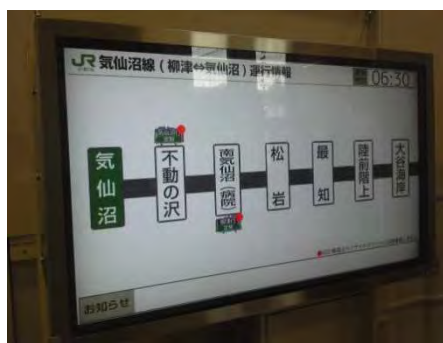
各駅に設置されたロケーションシステム（携帯電話でも確認可能）
