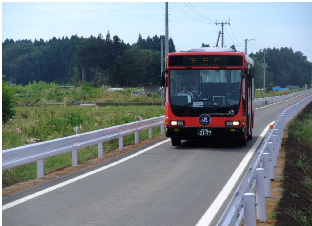
鉄道敷きを舗装して走る B R T（J R 気仙沼線）
