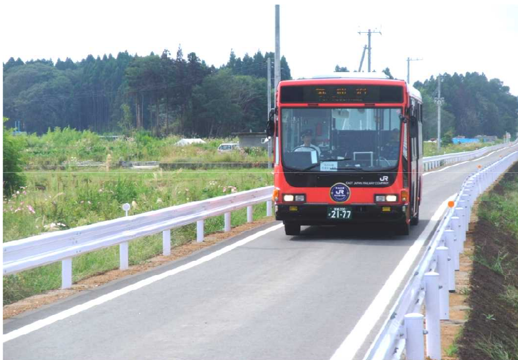
鉄道敷きを舗装した専用道走るBRT（J R気仙沼線）
