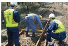
▲レール軌間の確認
