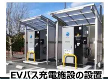
EVバス充電施設の設置
