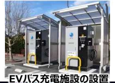
EVバス充電施設の設置
