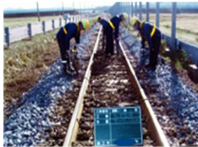
レールの修繕
