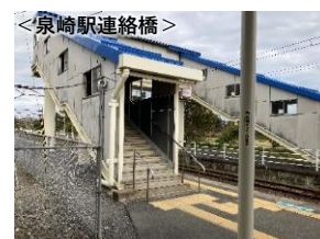
＜泉崎駅連絡橋＞ 連絡橋の誘導ブロック未設置、内方線の未設置
