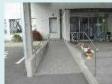
出入口の段差解消 事業費：30万円程度
