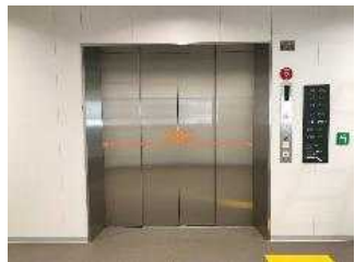
エレベーターの整備
