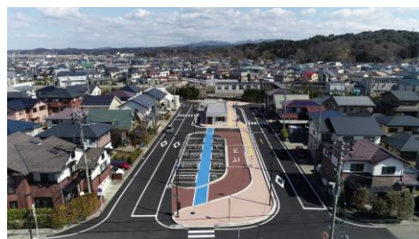
▲泉側駅前広場
