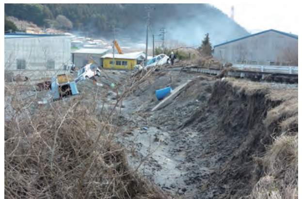
写真 2.11.1 法面の流出
